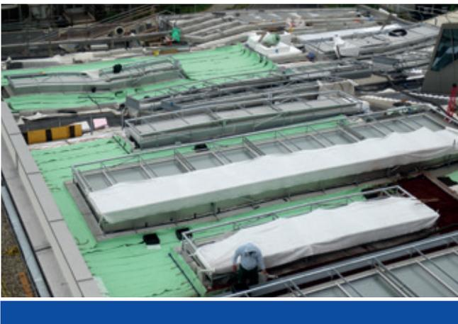
In gemäßigten Klimazonen ist die Dachbegrünung bisher das Haupteinsatzgebiet der iMat Bewässerungsmatte, da hier die meisten Vorteile zum Tragen kommen: Erhöhung der Wasserspeicher- und -leitfähigkeit des verwendeten Substrats. Verzicht auf die übliche Anstaubewässerung und damit geringere Anforderungen an Gewicht und Statik. Keine Mindestaufbauhöhe erforderlich, um Regner fixieren zu müssen. Mit unserer iMat Bewässerungsmatte werden nun auch Dachbegrünungen in ariden Klimazonen möglich.
