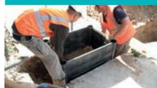
Modulare, variabel einsetzbare Ventilschächte, bestehend jeweils aus einer Bodenplatte mit Ring, weiteren Ringen und einem Deckel, je nach Anwendung. Hergestellt aus Polyethylen (HDPE). Verkehrsnorm NEN-EN 124. Verpackungseinheit: 1 Stück.
